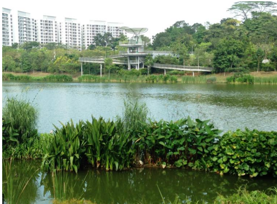
Slika 7: Pogled na spiralni toranj [7]
